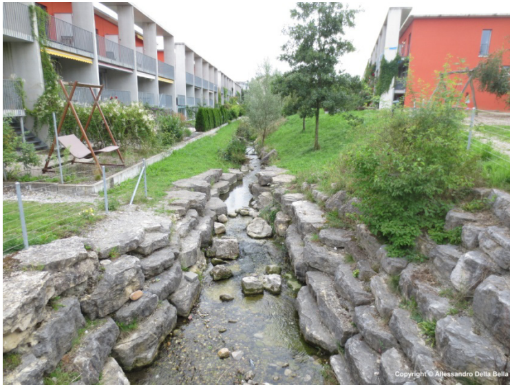
Abbildung 4: Beispiel eines tieferliegenden künstlichen Bachs. Die steilen, befestigten Ufer eignen sich für Bereiche mit wenig Platz wie dem letzten Stück Richtung Stampfenlochbach. Die flacheren, begrünten Ufer finden Anwendung bei mehr Platz wie in den Grünbereichen um den Quartierplatz.
