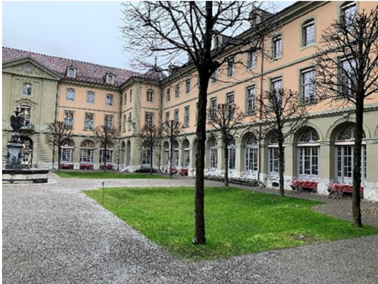
Abbildung 5: Versickerungsanlage in einem Innenhof als begrünte Bodensenke. Bildquelle: "Beispielsammlung guter Umgang mit Regenwasser", SVKI
