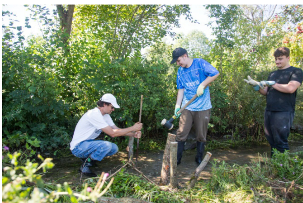
Strömungslenker im Bach werden errichtet
